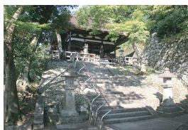
拝殿(法然上人の御廟を拝する建物)
