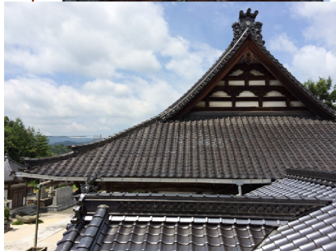
本堂東側屋根
