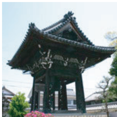
八幡別院鐘楼
